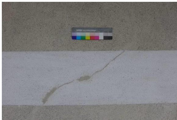
35_2023_7166_1 Zwischenzustand Gekitteter Riss vor der Retusche
