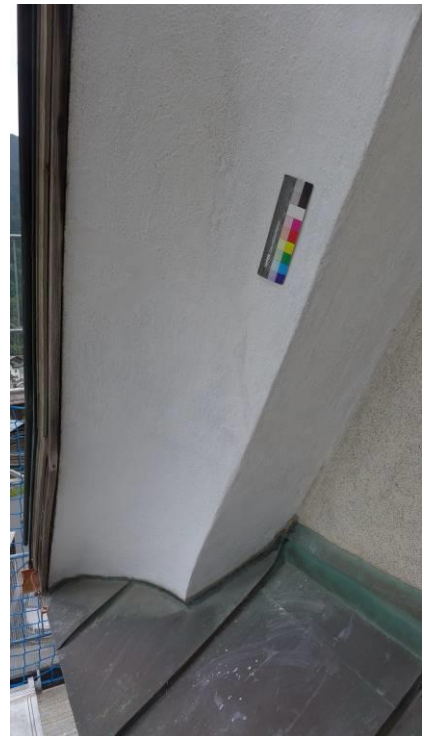
Abb.2 (rechts) Endzustand, mit Kalk re- tuschierte Kittungen
