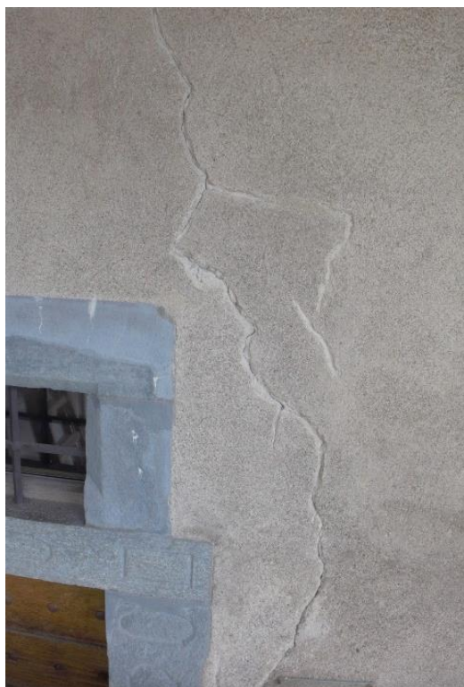
Abb.4 (links) Zwischenzustand, geöffnete Risse nach dem Entfernen alter Kittungen
