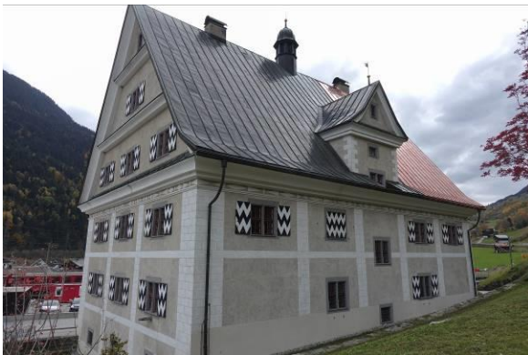
29_2023_7166_1 Vorzustand Nordfassade Übersicht
