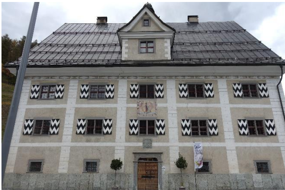
18_2023_7166_1 Vorzustand Südfassade Übersicht
