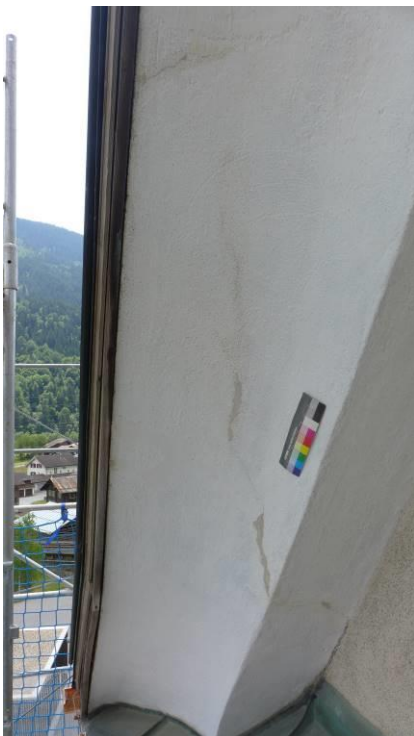
Abb.1 (links) Zwischenzustand, Kittungen mit Kalkmörtel
