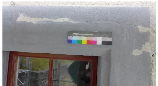
Abb.9 Zwischenzustand, gekittet Stellen in der Fenstereinfassung
