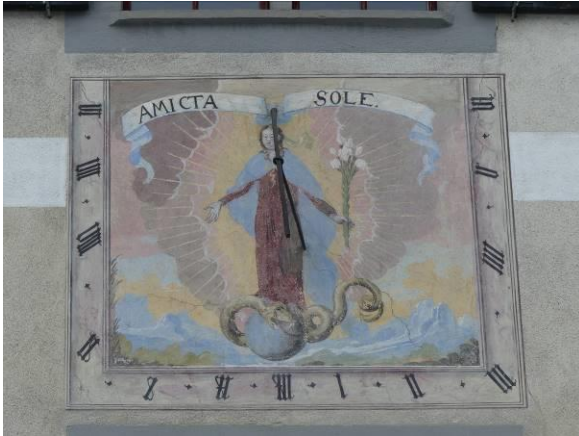
43_2023_7166_1 Wandmalerei Vorzustand Übersicht
