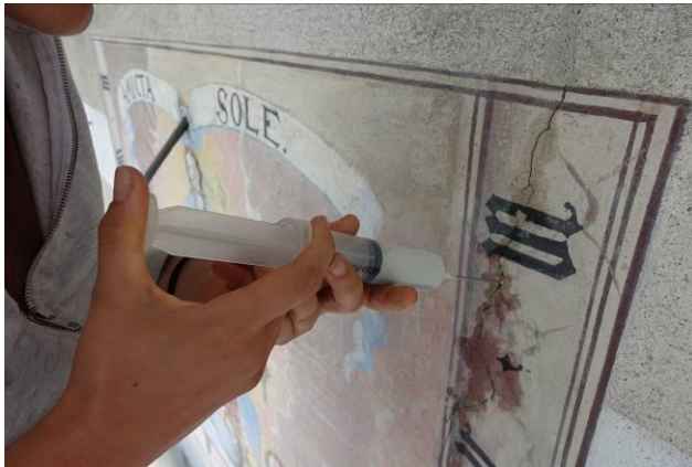
Abb.6 Zwischenzustand, Hinterfüllen von instabilen Putzbereichen
