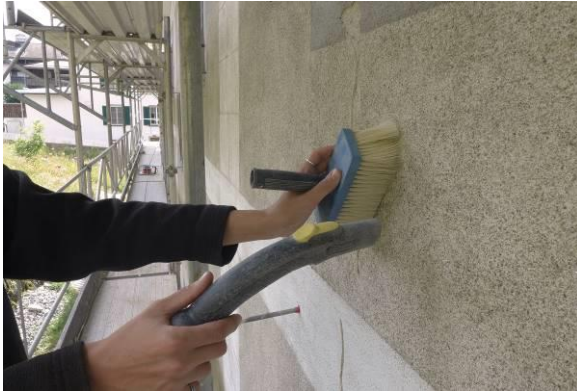
31_2023_7166_1 Zwischenzustand Oberflächenreinigung trocken
