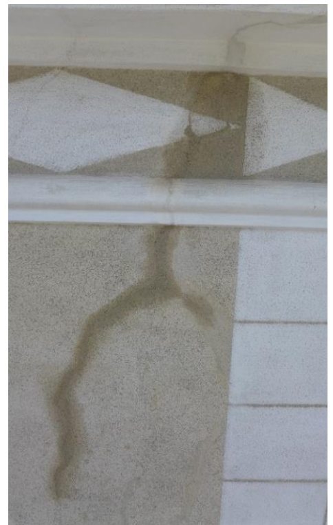
Abb.4 (links) Zwischenzustand, geöffnete Risse nach dem Entfernen alter Kittungen
