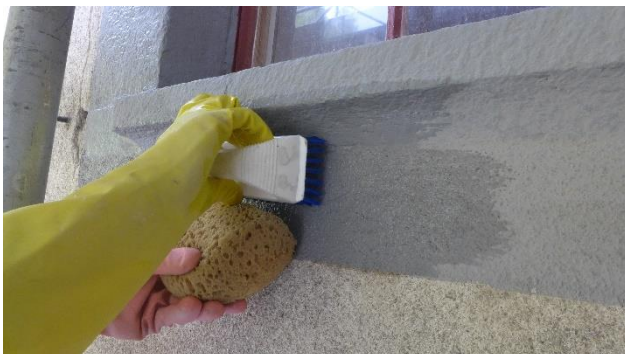
Abb.8 Zwischenzustand, Feuchtreinigung der Fenstereinfassungen
