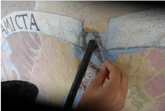
55_2023_7166_1 Wandmalerei Zwischenzustand Kitten von Fehlstellen mit Kalkmörtel
